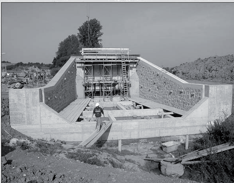
Das fast fertiggestellte Durchlaßbauwerk, von Oberwasser gesehen.
