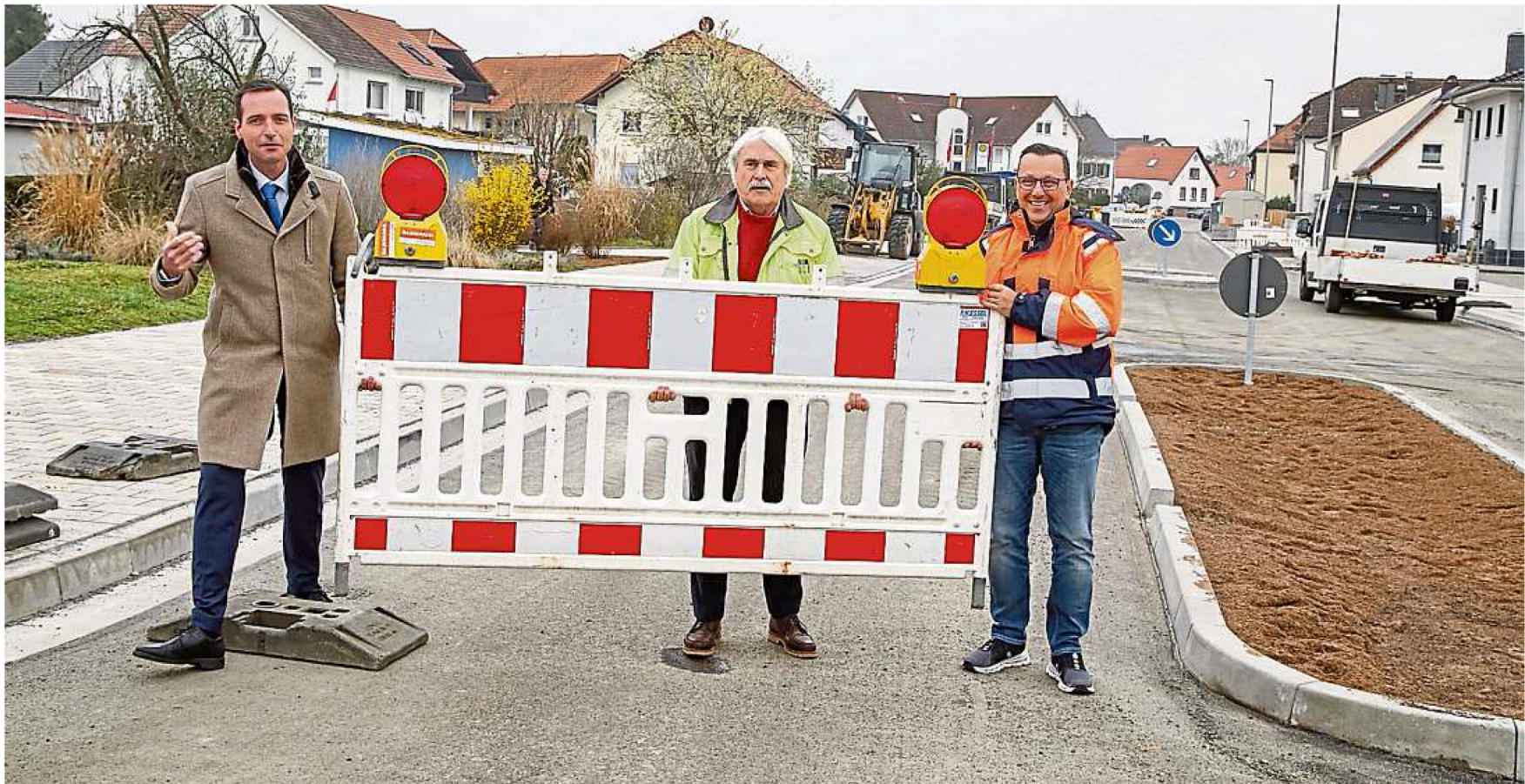
Bürgermeister Marcus Rahner (von links) wird beim Abbauen der Barrieren zur Ortsdurchfahrt von den beiden Bauleitern Franz Zior und Thomas Krost unterstützt. Seit 11 Uhr am Montag fließt der Verkehr wieder. Foto: Frank Möllenberg
